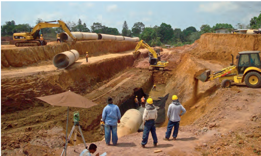
O-Tek provee 60 kilómetros de tubería para la instalación de un sistema de riego que llevará agua hasta la zona más árida de Lambayeque, Perú, como parte del megaproyecto hidráulico Olmos.
