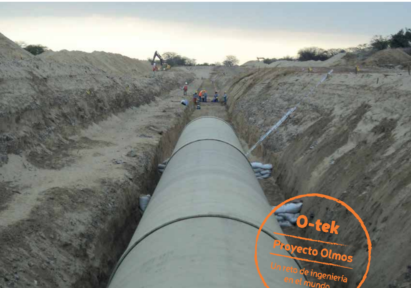
Perú. Proyecto de riego Olmos, 60 km de tubería O-tek.
